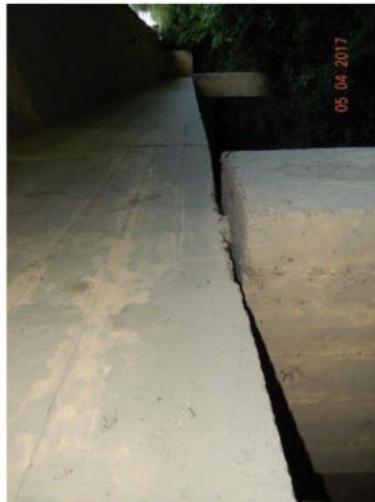
Foto 5. Vista do aparelho de apoio, em bom estado.
