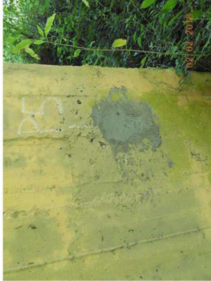
Foto 6. Vista da recomposição do local utilizado em ensaio de determinação da profundidade de carbonatação.
